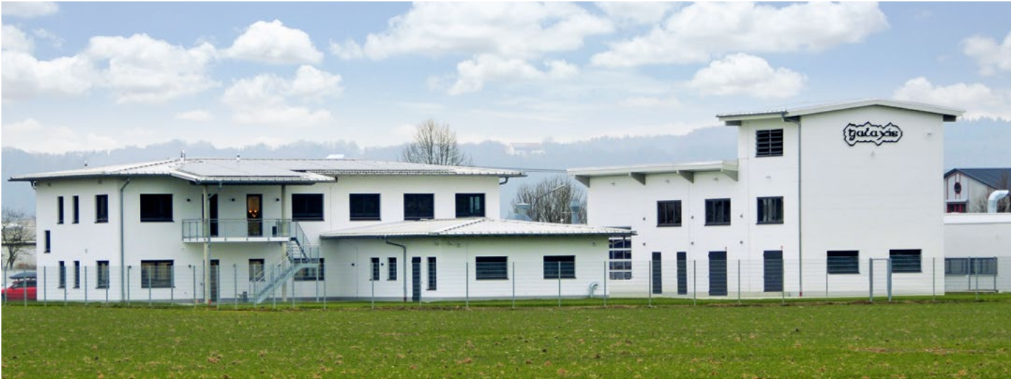
Betriebsgebäude der Galaxis Showtechnik GmbH Premises of Galaxis Showtechnik GmbH
